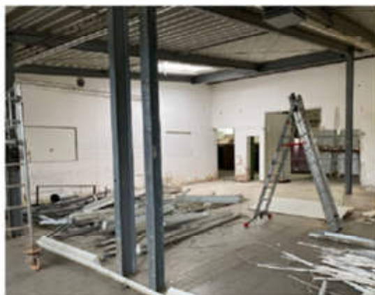
Während des Umbaus
